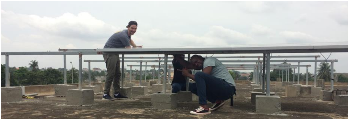
Figure 3 : Installation des sous-structures des panneaux solaires
