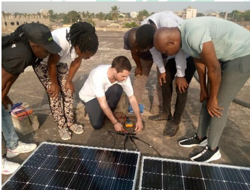
Figure 7: Formation des futurs agents de maintenance de l'installation
