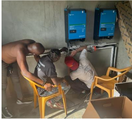
Figure 4: Installation des onduleurs
